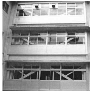
耐震化が完了した上本郷小学校
